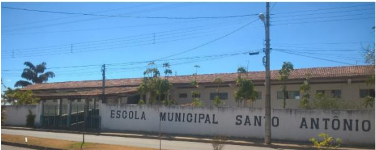
Figura 11 – Fachada da instituição em estudo, localizada em Arcos – MG.
